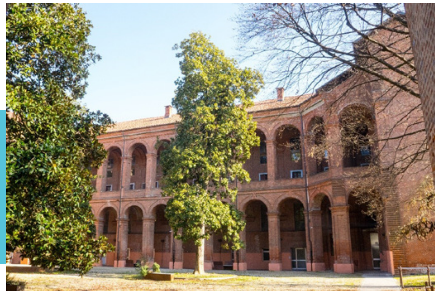
FIG. 8: Carmagnola – veduta cortile interno
