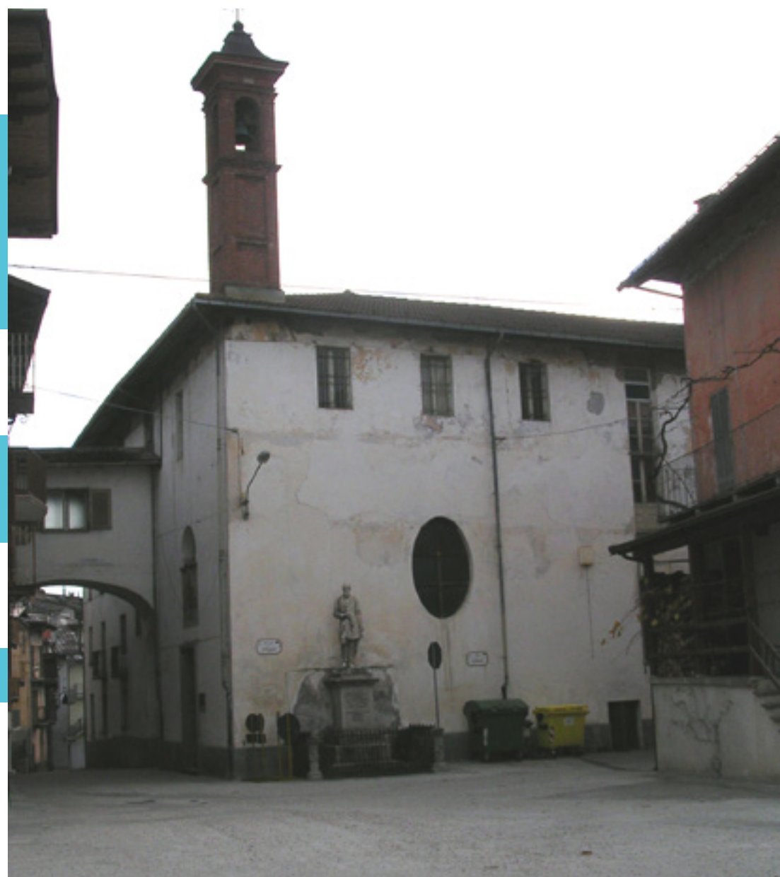
FIG. 9: Ex Ospedale Civile di Demonte
