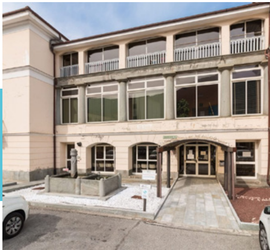
FIG. 8: Torre Pellice – ingresso ospedale valdese
