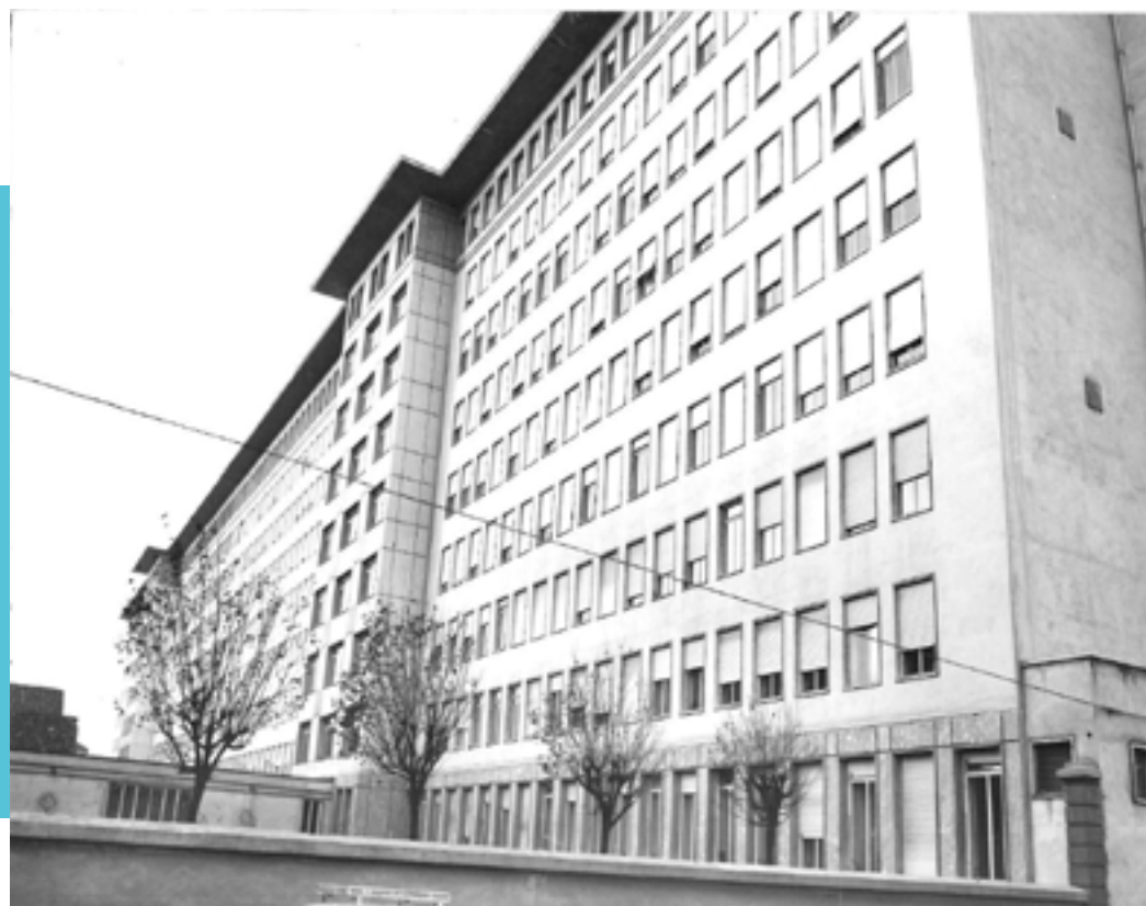
FIG. 5: Padiglione monoblocco (1959-1960 archivio fotografico Biblioteca Biomedica)
