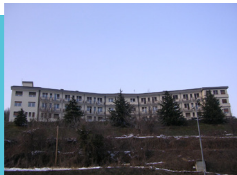
FIG. 10: Ex Ospedale Civile di Demonte
