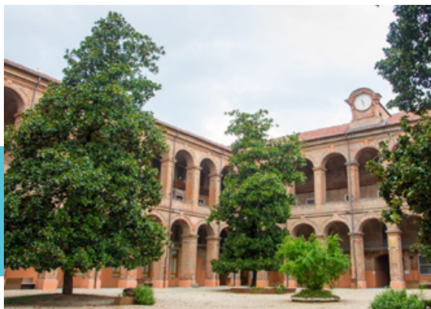
FIG. 7: Carmagnola – veduta cortile interno
